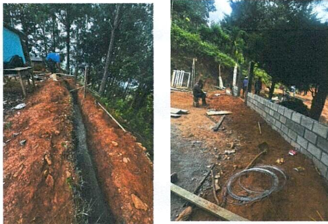
Foto 3: Proceso de la remodelación del muro perimetral, avanzando en la fundición y circulado de block.
