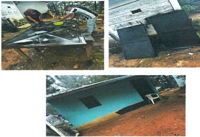
Foto1: Se realiza los trabajos de remodelacion de las puertas, baño y pintura de la cocina para un mejor ambiente de los espacios en el centro educativo.
